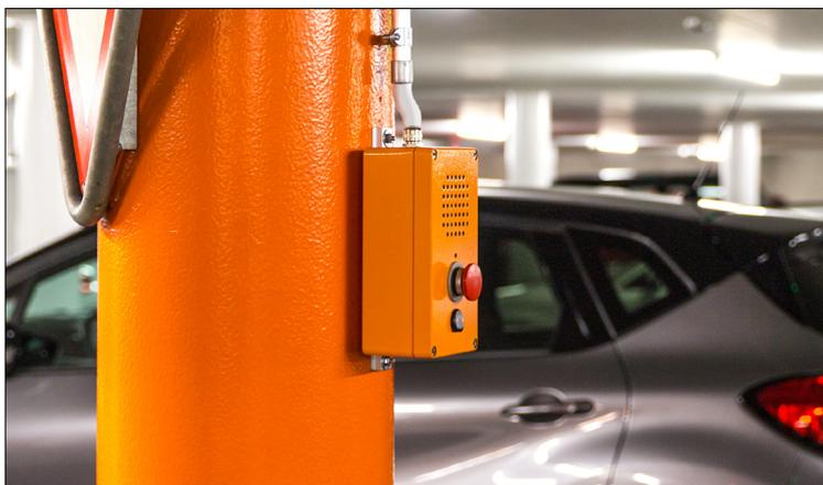
Les stations, dans un boîtier en fonte d'aluminium, sont également extrêmement robustes.
