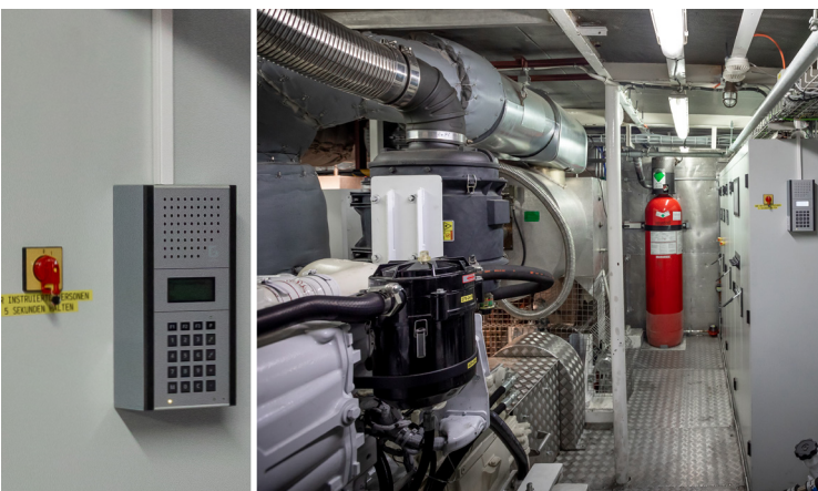
Im Maschinenraum dient eine Sprechstelle als modernes Sprachrohr zur Brücke.
