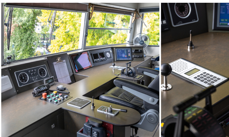
Dans la timonerie (pont supérieur), la station intercom est directement encastrée dans le tableau de bord.
