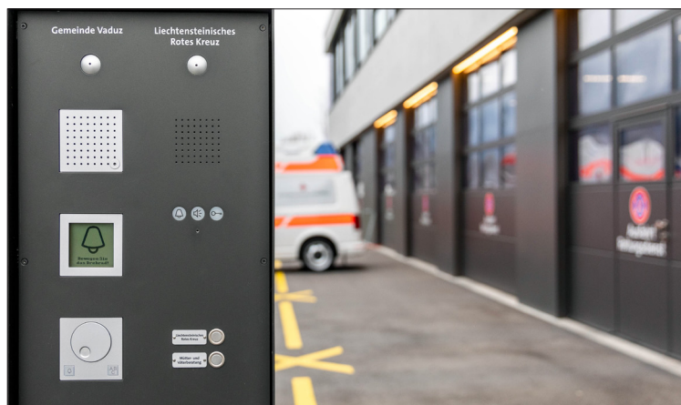
Zur Anmeldung sind diverse Aussensprechstellen am und im Gebäude platziert.
