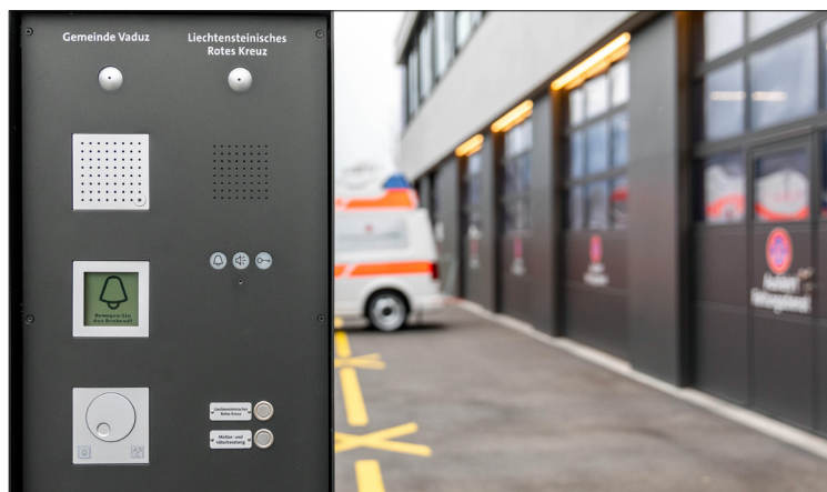
Diverses stations extérieures pour l'annonce des visiteurs sont positionnées à l'extérieur et dans le bâtiment.
